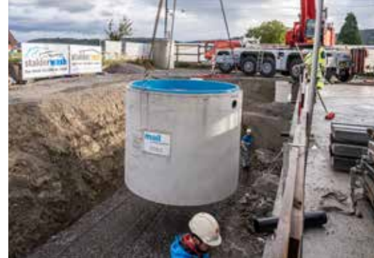
Behutsam wurden die Wasserbehandlungstanks mittels Pneukran in der Baugrube platziert, beobachtet von Fabian Stalder (rechts).
