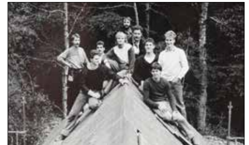
Elias Grütter (6. v. l.) während eines Lehrlingslagers in Schwarzenburg, wo eine Holzbrücke eingedeckt wurde.
