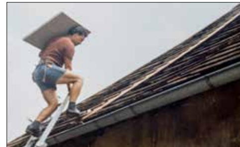
Heute undenkbar: Elias Grütter trägt ungesichert und mit Halbschuhen an den Füssen Kaminplatten auf einen Dachfirst.
