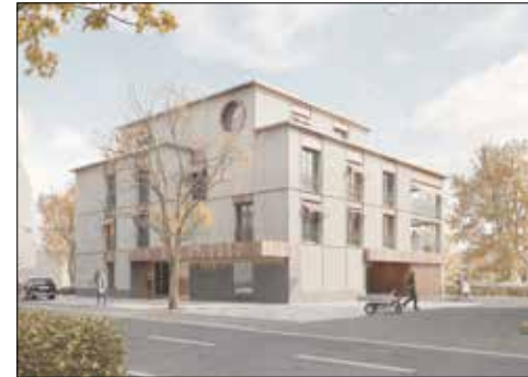
Visualisierung des künftigen Säuberlihauses: Mit der Immobilienstrategie der Stiftung Satis wird der Inklusionsgedanke der UNO-Behindertenrechtskonvention umgesetzt (Foto: nusos).
