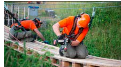
... und beim Errichten der Brücke.
