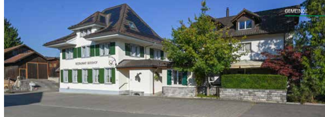
Im neuen Kleid: Das Restaurant Geisshof nach der gelungenen Sanierung mit der ins Ziegeldach integrierten PV-Anlage.
