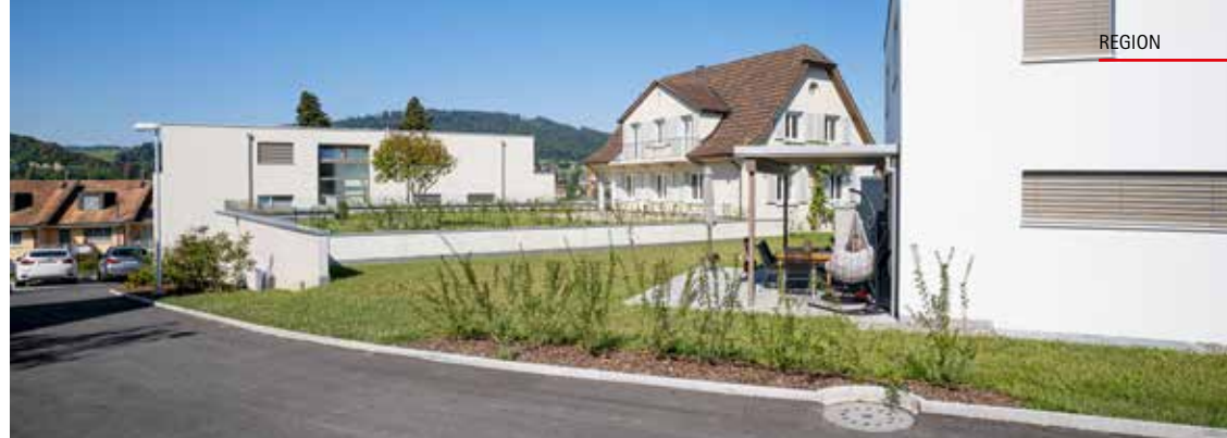
Das Ensemble mit dem neuen Mehrfamilien- und Einfamilienhaus mit dem bestehenden und renovierten Landhaus im Zentrum.
