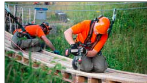
... und beim Errichten der Brücke.
