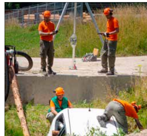
Pioniere beim Vorbereiten der Bergung des Autos.
