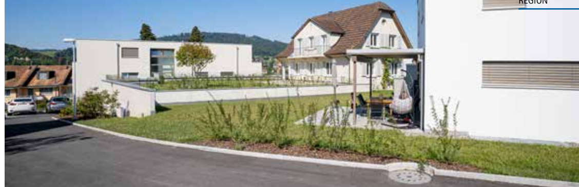
Das Ensemble mit dem neuen Mehrfamilien- und Einfamilienhaus mit dem bestehenden und renovierten Landhaus im Zentrum.
