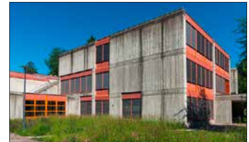
Das Flachdach des Menzoschulhauses kann saniert werden.
