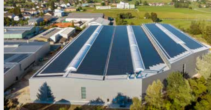
Die Photovoltaikanlage auf der Halle 5.
