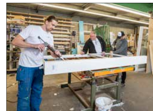
Vorbereitungen für die Fenster-Montagen in der Werkstatt.
