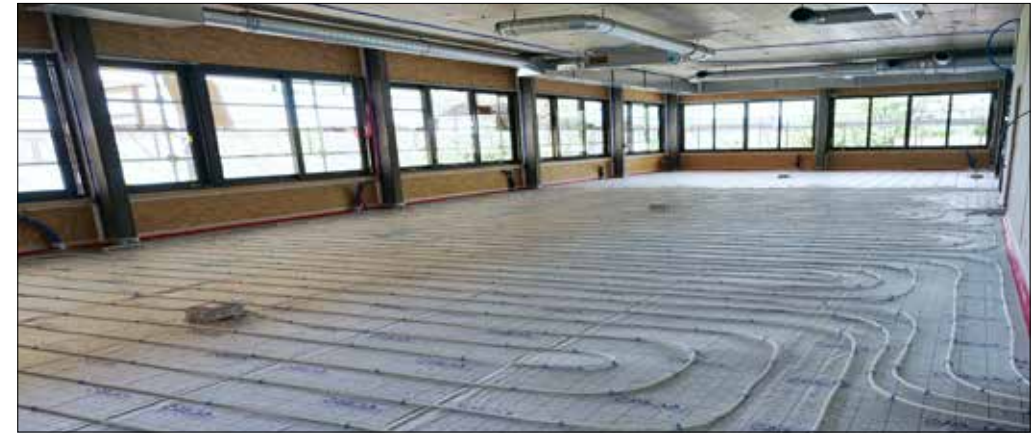
Der grosse Bankettsaal nimmt langsam Form an.
